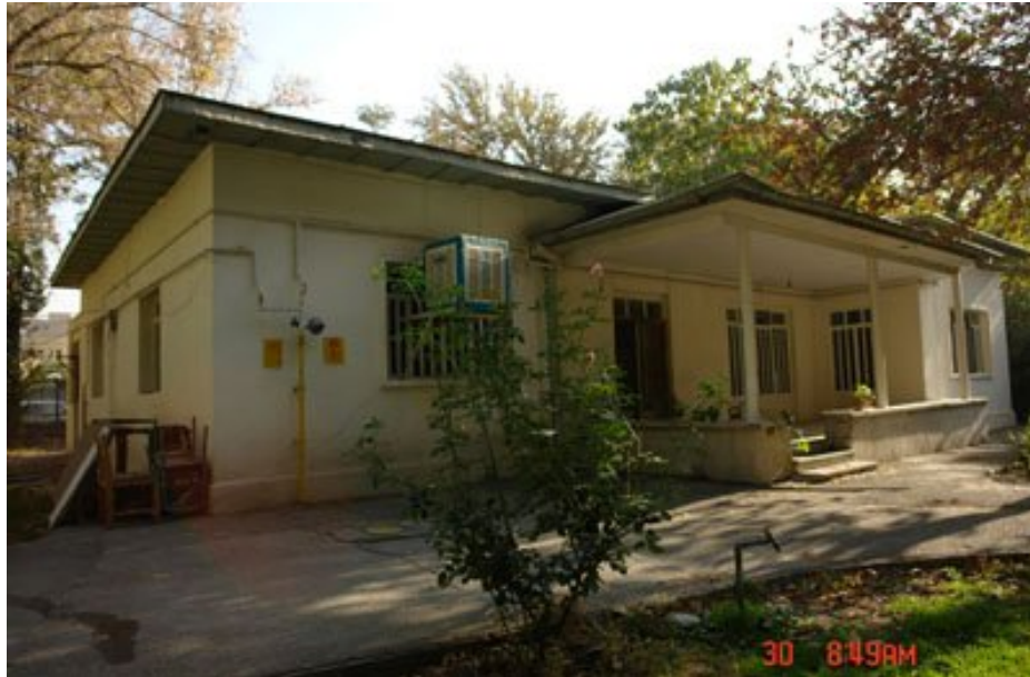
شکل (۲۴): نمایی از ساختمان مرکز کارآفرینی پردیس کشاورزی و منابع طبیعی دانشگاه تهران
